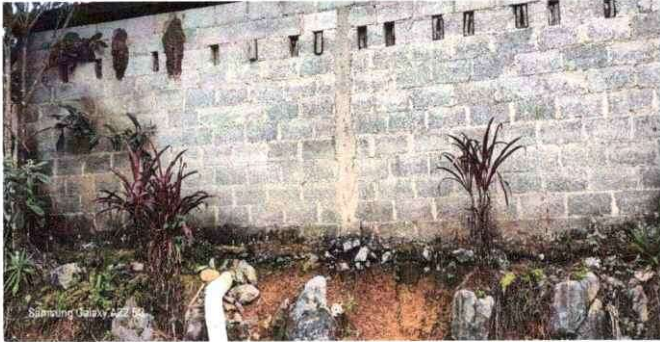
Foto 1: En esta fotografía muestra la parte donde se refuerza con 6 columnas para evitar caída del aula de 16 metros de largo.
