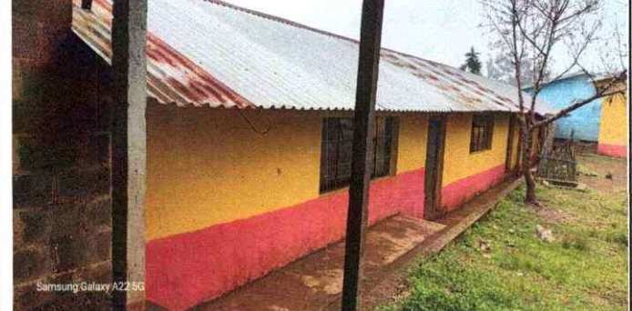
Foto 4: En esta fotografía muestra la parte norte del aula donde se coloca 11 columnas para reforzar el aula y dejar bien forzado. Y también muestra la parte donde se instalan 11 columnas para cubrir de laminas el corredor
