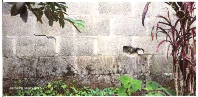
Foto 2: En esta imagen muestra la segunda parte donde se colocan 5 columnas de reforzamiento del aula de 16 metros de largo.
